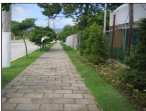
Figura 99. Vala de retenção ao longo da rua
