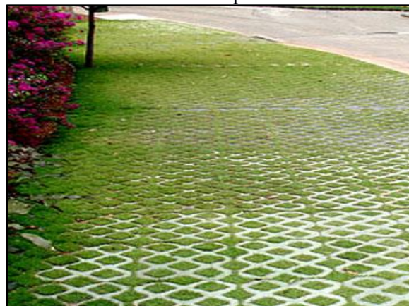
Figura 94. Pavimento poroso – concregrama instalado em passeio
