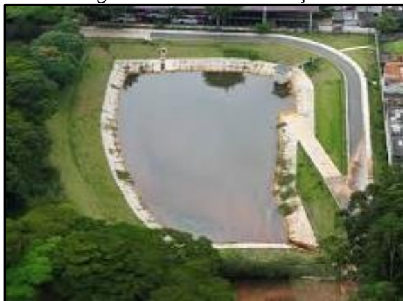
Figura 101. Bacia de detenção
