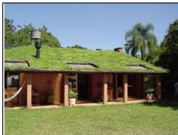
Figura 92. Telhado verde com plantas
