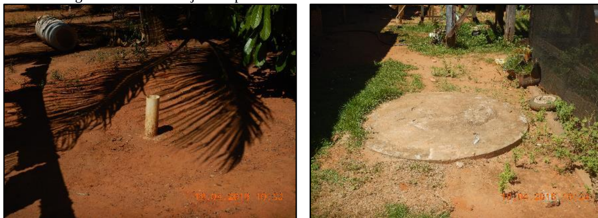
Figura 68. Vista da laje e suspiro de fossas rudimentares no assentamento Casulo
