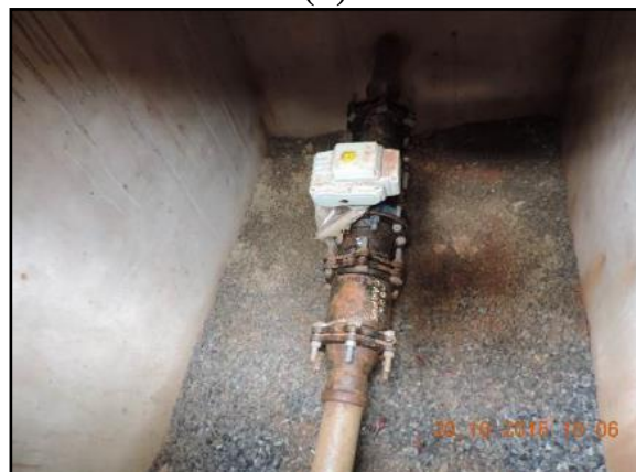
Figura 13. Detalhe das tubulações de PVC no REL-01(A) e registro elétrico na saída do REL 01 (B) (A) (B)
