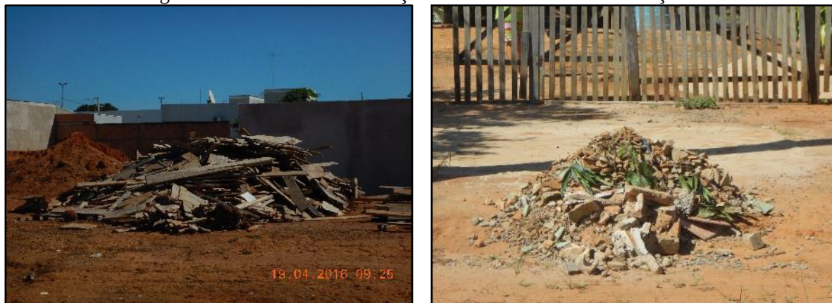
Figura 59. Resíduos da construção civil acondicionado nas calçadas
