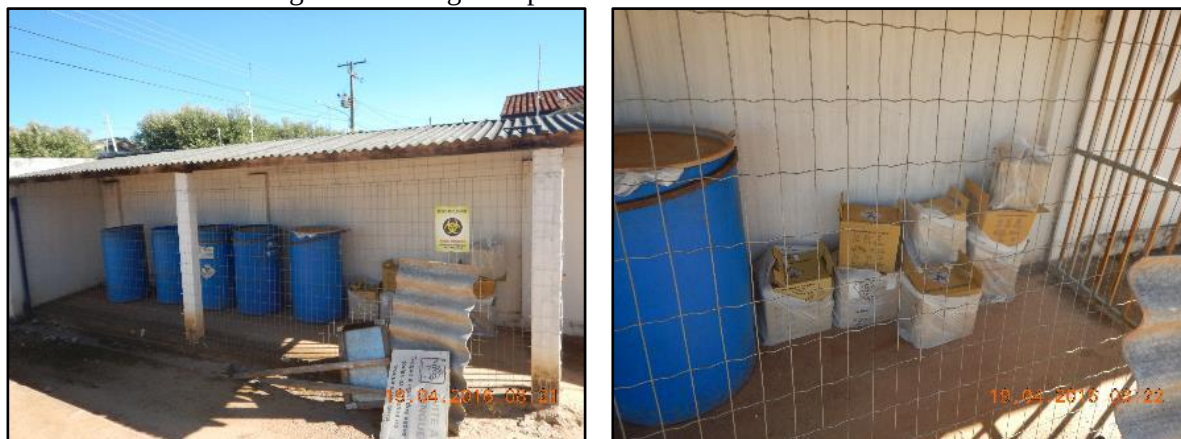
Figura 57. Abrigo temporário dos RSS de Santa Carmem
