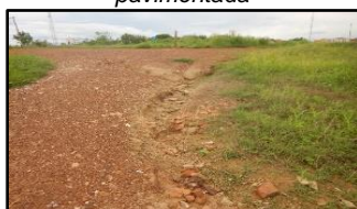
Figura 2251. Erosão em via não pavimentada
