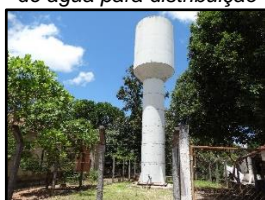
Figura 2204. Reservatório de água para distribuição
