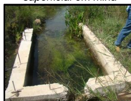
Figura 2225. Captação superficial em mina
