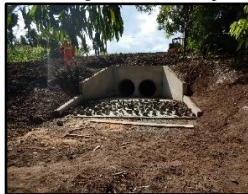
Figura 2136. Dissipador de energia em execução
