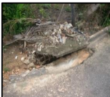
Figura 2233. Boca de lobo danificada
