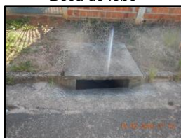
Figura 2155. Boca de lobo
