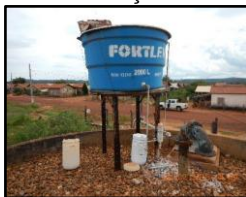
Figura 2185. Sistema de cloração
