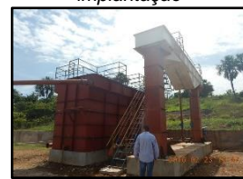
Figura 2226. ETA em implantação
