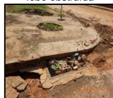
Figura 2158. Boca de lobo obstruída
