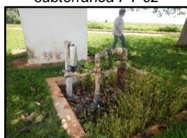
Figura 2166. Captação subterrânea PT-02
