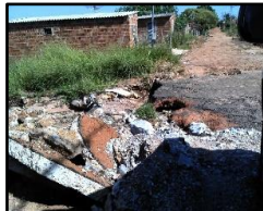
Figura 2137. Asfalto danificado
