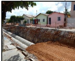
Figura 2135. Obra de drenagem em execução
