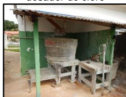
Figura 2129. Sistema dosador de cloro
