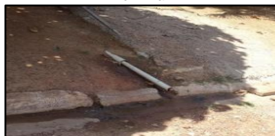
Figura 2248. Lançamento de águas servidas em via
