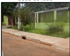
Figura 2173. Via com boca de lobo
