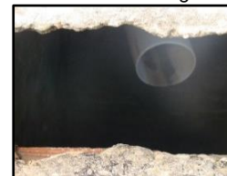
Figura 2234. Lançamento clandestino de esgoto
