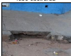
Figura 2270. Boca de lobo obstruída
