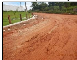
Figura 2231. Rua de bairro sem pavimentação
