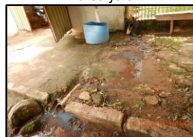
Figura 2189. Esgoto lançado na sarjeta
