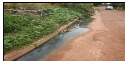
Figura 2249. Esgoto correndo a céu aberto
