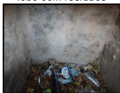
Figura 2211. Boca de lobo com resíduos
