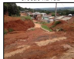
Figura 2176. Grande erosão na rua
