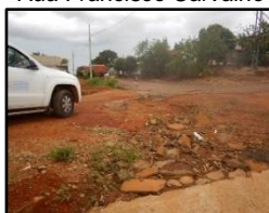
Figura 2175. Erosão na Rua Francisco Carvalho
