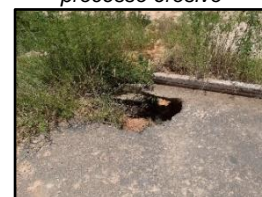
Figura 2273. Ponto com processo erosivo
