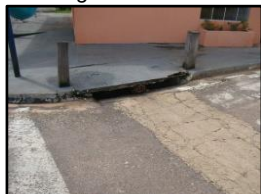
Figura 2230. Dispositivo de drenagem boca de lobo
