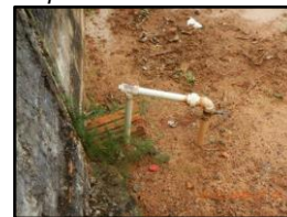
Figura 2187. Ligação predial sem medidor
