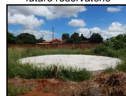
Figura 2169. Base do futuro reservatório
