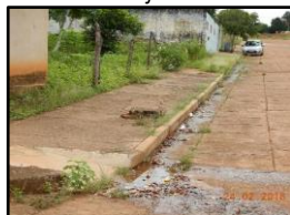
Figura 2192. Dispositivo de drenagem- meio-fio e sarjeta
