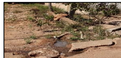
Figura 2268. Lançamento de esgoto na rua
