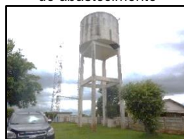
Figura 2245. Reservatório de abastecimento
