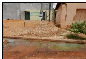
Figura 2190. Esgoto na via urbana
