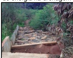
Figura 2174. Dissipador de energia na drenagem
