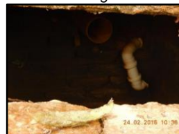
Figura 2195. Ligações de esgoto em rede de drenagem
