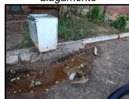
Figura 2272. Ponto de alagamento
