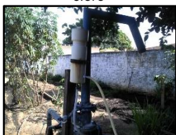
Figura 2223. Dosador de cloro
