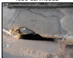
Figura 2269. Boca de lobo danificada
