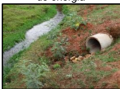
Figura 2210. Dissipador de energia
