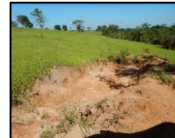
Figura 2139. Processo de erosão
