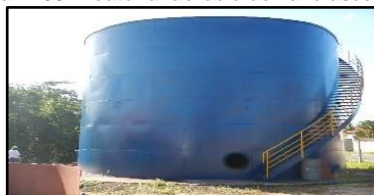
Figura 2133. Reator anaeróbio de fluxo ascendente
