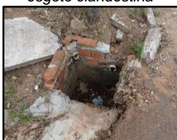
Figura 2271. ligação de esgoto clandestina
