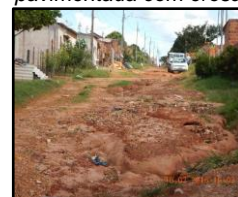
Figura 2159. Via não pavimentada com erosão
