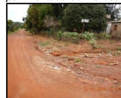
Figura 2196. Via não pavimentada com erosão
