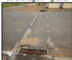
Figura 2156. Dispositivo de drenagem - grelha
