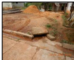
Figura 2193. Dispositivo de drenagem- boca de lobo
