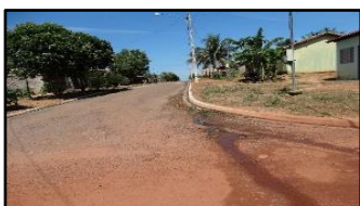
Figura 2250. Acúmulo de água
