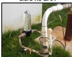
Figura 2167. Dosador de cloro no SAA
