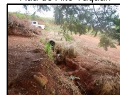
Figura 2177. Erosão na Rua de Alto Taquari
