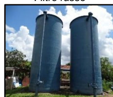
Figura 2205. ETA - Filtro russo
