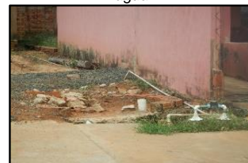
Figura 2172. Fossa próxima à ligação de água
