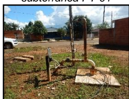
Figura 2165. Captação subterrânea PT-01
