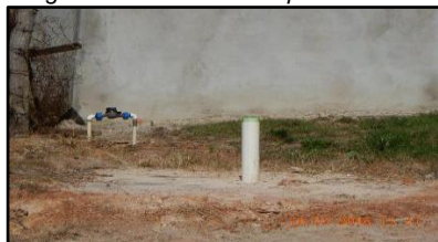
Figura 2152 Vista de suspiro de fossa
