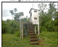
Figura 2243. Captação e abrigo de clorador
