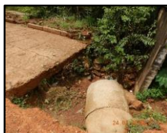
Figura 2194. Meio-fio e sarjeta danificados
