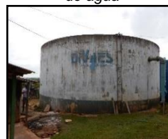
Figura 2130. Reservatório de água
