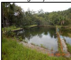
Figura 2147. Barragem no córrego Lajeado
