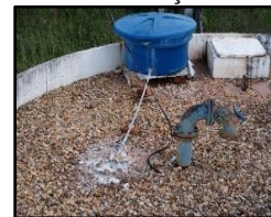
Figura 2265. Sistema de desinfecção
