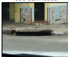
Figura 2212. Boca de lobo danificada
