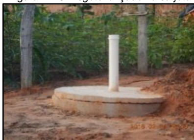
Figura 2228. Esgoto lançado na sarjeta
