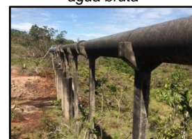
Figura 2206. Adutora de água bruta
