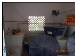
Figura 2150. Desinfecção com cloro
