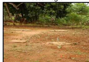
Figura 2188 Laje e suspiro de fossa negra
