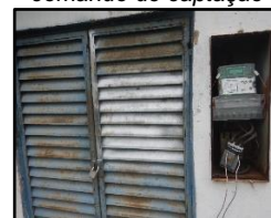
Figura 2246. Quadro de comando de captação
