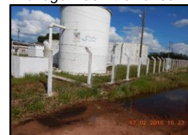
Figura 2151. Água de lavagem de filtro na rua
