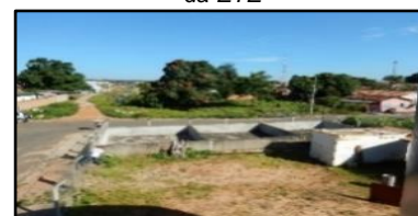
Figura 2134. Leito de secagem de lodo da ETE
