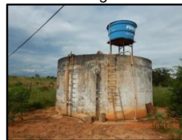
Figura 2186. Reservatório de água
