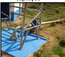
Figura 1504. Poço tubular para captação
