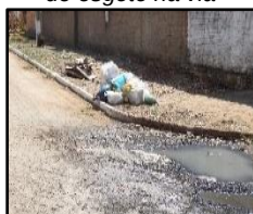
Figura 1469. Acúmulo de esgoto na via
