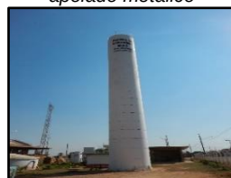
Figura 1465. Reservatório apoiado metálico
