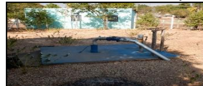
Figura 1522. Vala para disposição dos resíduos no assentamento Santo Idelfonso
