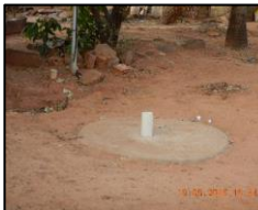
Figura 1569. Fossa instalada em um terreno
