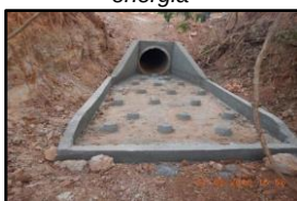
Figura 1575. Dissipador de energia
