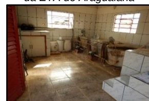
Figura 1466. Casa de química da ETA de Araguaiana
