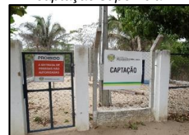
Figura 1485. Área de acesso à captação superficial
