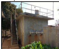
Figura 1566. ETA compacta de concreto
