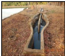
Figura 1548. Caixa de areia da ETE
