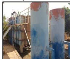
Figura 1567. ETA compacta metálica
