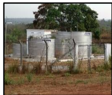
Figura 1488. Vista geral da ETE
