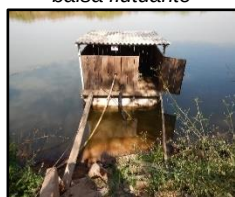
Figura 1463. Abrigo da balsa flutuante
