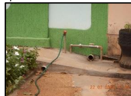
Figura 1527. Ligação predial não hidrometrada
