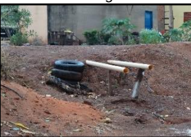
Figura 1490. Ponto de descarga de esgoto
