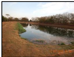
Figura 1549. Lagoa facultativa na ETE
