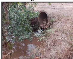
Figura 1513. Despejo de águas pluviais no córrego Fundo
