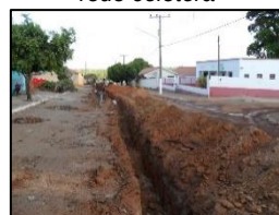
Figura 1470. Execução da rede coletora
