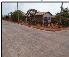
Figura 1491. Rua pavimentada com meio-fio e sarjeta
