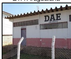
Figura 1462. Sede da ETA Araguaiana
