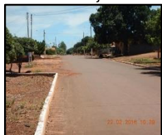
Figura 1532. Via pavimentada com meio-fio e sarjeta
