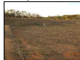
Figura 1551. Lagoa de maturação seca na ETE
