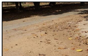
Figura 1473. Rua pavimentada com erosão e sedimentos
