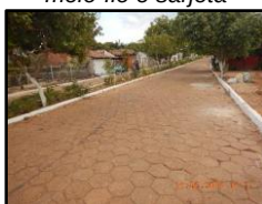
Figura 1576. Via com meio-fio e sarjeta
