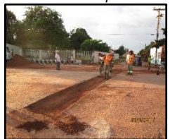
Figura 1486. Execução do interceptor
