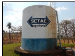
Figura 1506. Reservatório R-01 na sede da SETAE
