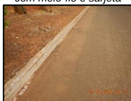
Figura 1554. Via pavimentada com meio-fio e sarjeta
