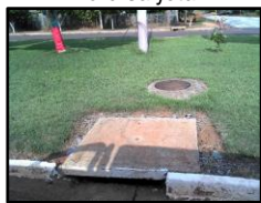
Figura 2109. Rua pavimentada com meio-fio e sarjeta
