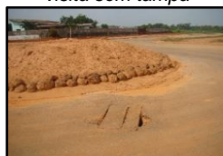
Figura 2033. Poço de visita sem tampa
