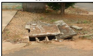
Figura 2074. Boca de lobo danificada
