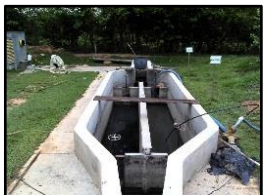
Figura 2048. Gradeamento e desarenador na ETE
