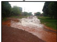
Figura 2015. Ponto de alagamento
