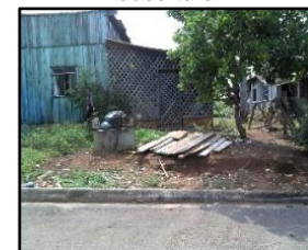
Figura 2108. Fossa rudimentar sem laje de cobertura
