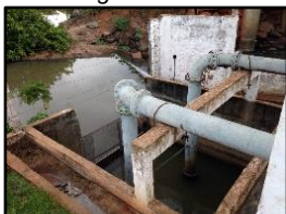
Figura 2043. Captação no córrego Alcebiades
