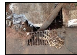
Figura 2113. Boca de lobo danificada na Av. Zé Paraná
