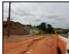
Figura 2055. Erosão na Rua Boa Vista
