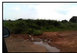
Figura 2111. Erosão na Rua Paraíba
