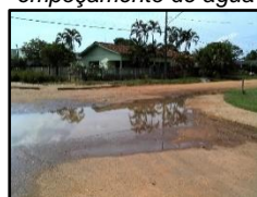
Figura 2091. Ponto de empoçamento de água
