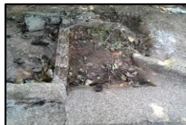
Figura 2057. Boca de lobo obstruída com terra
