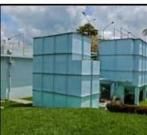
Figura 2045. Vista da ETA metálica
