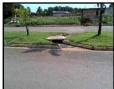
Figura 2054. Boca de lobo
