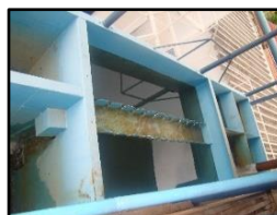
Figura 2068. Vista superior - ETA 2
