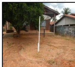
Figura 2070. Fossa instalada em Novo Horizonte do Norte
