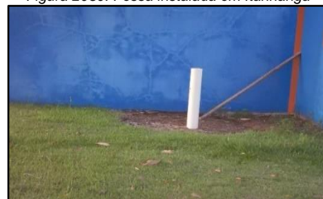
Figura 2030. Fossa instalada em Itanhangá
