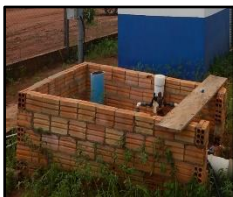
Figura 2027. Poço tubular PT-05
