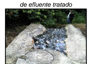
Figura 2052. Córrego dos Saltos no local de recebimento de efluente tratado
