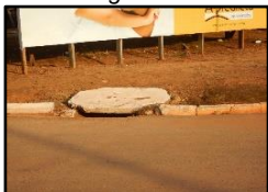
Figura 2013. Dispositivo de drenagem existente
