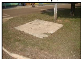
Figura 2072. Poço de visita no município
