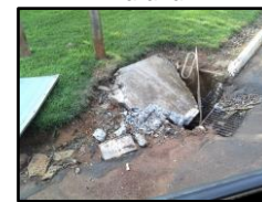
Figura 2112. Boca de lobo danificada na Av. Zé Paraná
