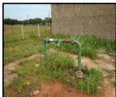
Figura 2026. Poço tubular PT-01
