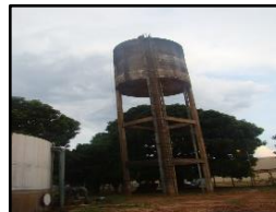
Figura 2010. Reservatório elevado REL-01
