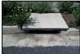
Figura 2053. Boca de lobo
