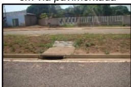
Figura 2031. Boca de lobo em via pavimentada
