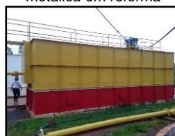
Figura 2105. ETA 1 metálica em reforma
