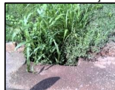
Figura 2056. Boca de lobo sem manutenção
