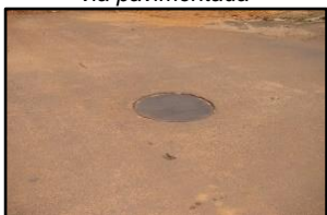
Figura 2073. Boca de lobo em via pavimentada
