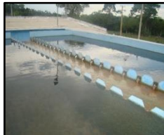
Figura 2067. Decantador de alta taxa - ETA 1
