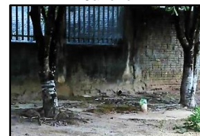
Figura 2089. Fossa implantada na Rua Rio de Janeiro
