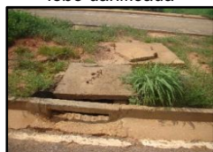
Figura 2032. Boca de lobo danificada
