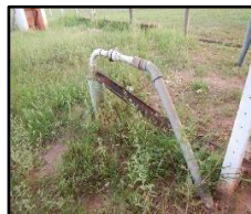
Figura 2008. Poço tubular PT-02
