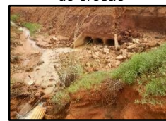
Figura 2035. Processo de erosão
