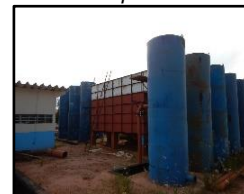
Figura 2011. Nova obra de ETA paralisada
