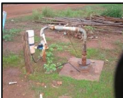
Figura 2009. Clorador de contato
