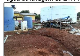
Figura 2106. Descarte de água de lavagem da ETA 1
