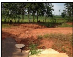
Figura 2110. Erosão na Rua Sandra, esquina com a Rua Wilson Geovedi
