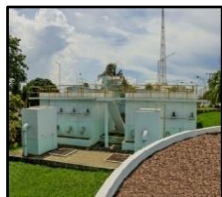
Figura 2044. Vista das 2 ETAs de concreto
