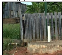
Figura 2107. Fossa rudimentar ao lado da ligação de água
