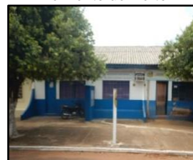
Figura 2071. Fossa instalada em Novo Horizonte do Norte
