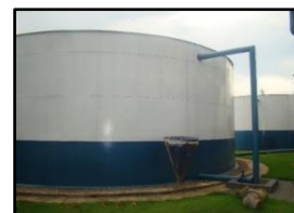
Figura 2069. Reservatório metálico RAP-02
