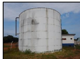
Figura 2028. Reservatório metálico RAP-01
