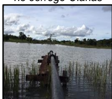
Figura 2103. Captação no córrego Olarias
