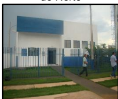
Figura 2065. Sede do DAE de Novo Horizonte do Norte
