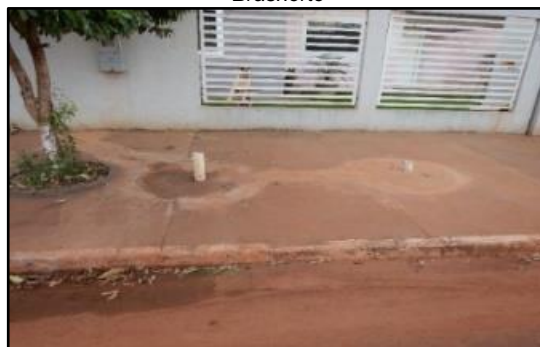
Figura 2012. Fossas instaladas em residência em Brasnorte
