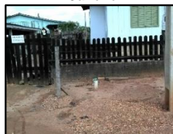
Figura 2088. Fossa implantada na Rua Rio de Janeiro
