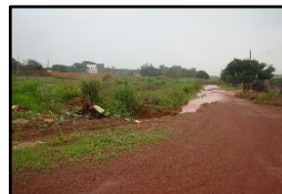
Figura 2016. Ponto de erosão em Brasnorte
