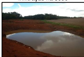
Figura 1300. Bacia de infiltração na sede
