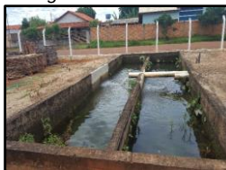
Figura 1334. Leito de secagem da água de lavagem do filtro de areia
