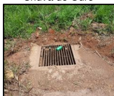
Figura 1341. Boca de lobo com grelha na Rua Chuva de Ouro
