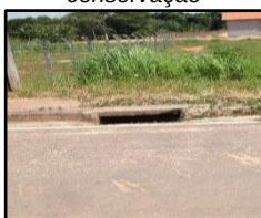
Figura 1424. Boca de lobo em bom estado de conservação
