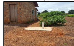
Figura 1339. Fossa instalada no município
