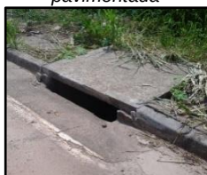
Figura 1423. Boca de lobo em via pavimentada
