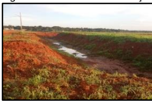
Figura 1302. Valas de infiltração
