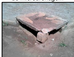
Figura 1444. Boca de lobo de microdrenagem
