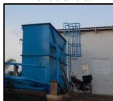
Figura 1395. ETA metálica de Rondolândia
