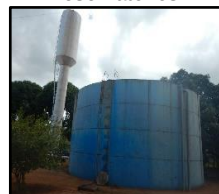
Figura 1296. Visão dos reservatórios
