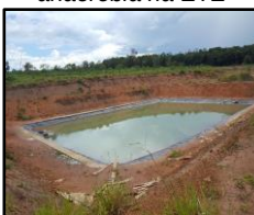
Figura 1316. Lagoa anaeróbia na ETE
