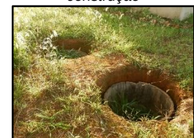
Figura 1299. Fossa séptica seguida de sumidouro em construção
