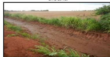
Figura 1303. Vala de infiltração na sede urbana
