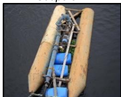
Figura 1434. Captação superficial no rio Guaporé
