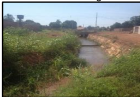
Figura 1382. Trecho canalizado do córrego Buriti
