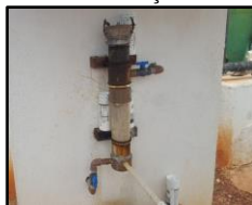
Figura 1333. Dispositivo de cloração e fluoretação
