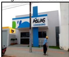
Figura 1309. Sede da Águas de Comodoro
