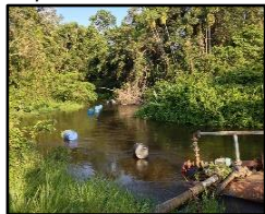
Figura 1350. Captação superficial no rio Galera
