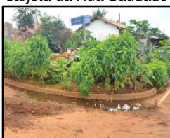
Figura 1342. Águas servidas estagnadas na sarjeta da Rua Saudade
