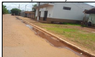
Figura 1338. Águas servidas lançadas na sarjeta
