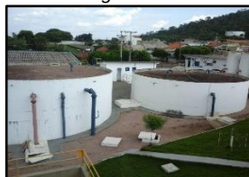
Figura 1375. Reservatórios de água tratada
