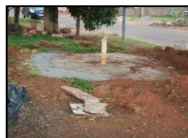
Figura 1298. Fossa instalada em calçada
