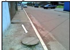
Figura 1439. Caixa de passagem instalada
