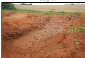
Figura 1301. Bacia de infiltração
