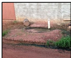
Figura 1355. Fossa instalada na calçada
