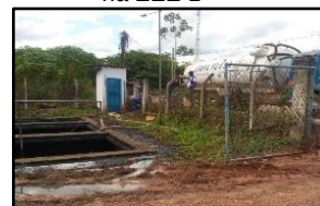
Figura 1421. Extravasamento de esgoto na EEE 1
