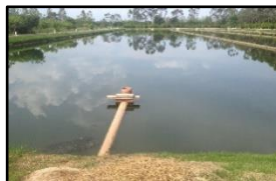
Figura 1380. Lagoa facultativa na ETE
