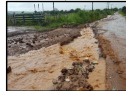
Figura 1323. Alagamento na Rua Espírito Santo
