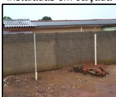
Figura 1314. Fossas instaladas em calçada
