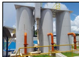
Figura 1312. Filtros de fluxo descendentes
