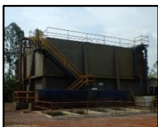
Figura 1378. Reator anaeróbio na ETE
