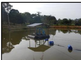
Figura 1394. Captação superficial no Igarapé São Gabriel
