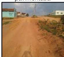
Figura 1400. Via não pavimentada
