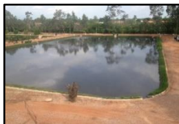
Figura 1379. Lagoa anaeróbia na ETE
