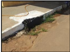
Figura 1319. Boca de lobo em via pavimentada
