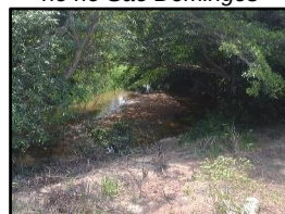
Figura 1425. Assoreamento no rio São Domingos
