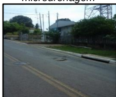
Figura 1422. Via pavimentada com microdrenagem
