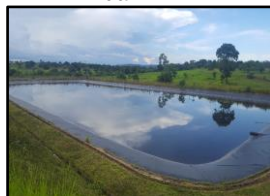
Figura 1336. Lagoa facultativa da ETE
