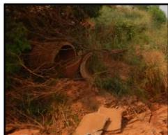
Figura 1008. Boca de lobo obstruída
