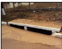
Figura 1090. Bueiro duplo tubular de concreto com dissipador de energia
