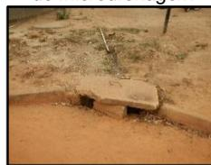
Figura 1030. Lançamento de esgoto
