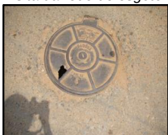
Figura 132. Poço de visita da rede de esgoto
