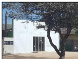
Figura 228. Fachada do DAE de Porto Estrela
