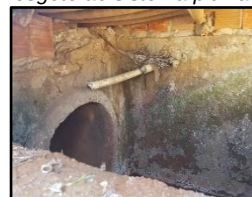
Figura 119. Ligação de esgoto ao sistema pluvial
