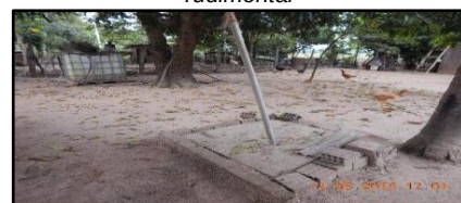
Figura 170. Vista da tampa de uma fossa rudimentar
