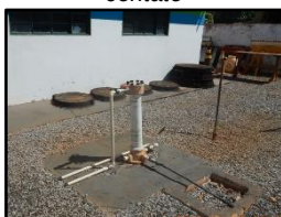
Figura 272. Clorador tipo contato
