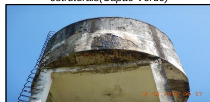
Figura 43. Reservatório com problemas estruturais (Capão Verde)
