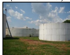
Figura 213. Reservatório (RAP-01 e RAP-02)
