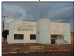
Figura 44. Sede Águas de Arenápolis
