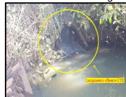
Figura 233. Lançamento do efluente no córrego
