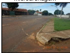
Figura 278. Via com microdrenagem
