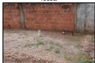
Figura 49. Vista da laje da fossa
