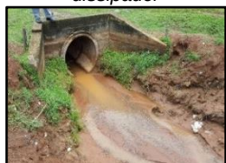
Figura 238. Deságue sem dissipador
