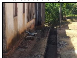
Figura 113. Lançamento na rede de drenagem
