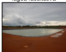
Figura 293. Vista da lagoa facultativa
