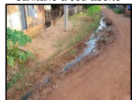
Figura 114. Esgoto sanitário a céu aberto
