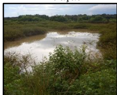
Figura 297. Bacias de infiltração
