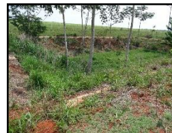
Figura 259. Vista da lagoa facultativa
