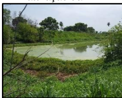
Figura 69. Lagoa de maturação da ETE
