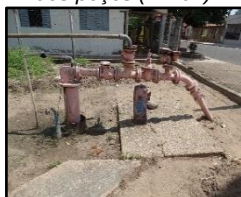
Figura 172. Estruturas dos poços (PT-01)
