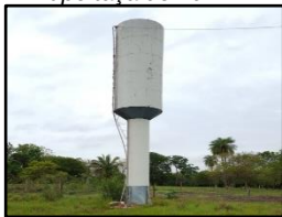
Figura 230. Reservatório tipo taça de 40 m 3
