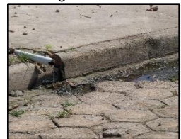
Figura 179. Despejo de água servida
