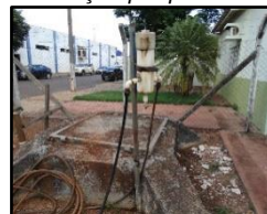
Figura 89. Dispositivo de cloração por pastilha
