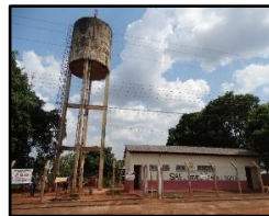
Figura 254. Vista frontal do reservatório
