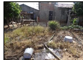
Figura 180. Transbordamento de fossa
