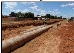
Figura 95. Obras de drenagem
