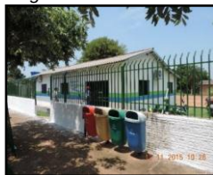
Figura 149. Sede da Águas de Nortelândia
