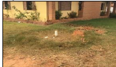
Figura 196. Vista externa de fossa rudimentar
