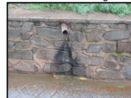
Figura 158. Lançamento no canal de drenagem
