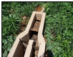
Figura 257. Grades na entrada do sistema
