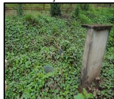
Figura 234. Falta de manutenção na ETE
