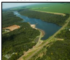
Figura 299. Barragem sob a BR-364
