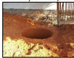
Figura 72. Fossa em construção na calçada
