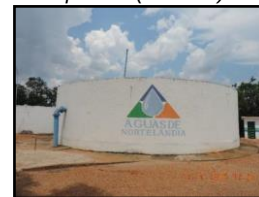
Figura 153. Reservatório apoiado (RAP-01)
