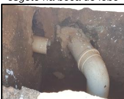
Figura 112. Ligação de esgoto na boca de lobo
