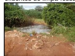
Figura 296. Descarte de efluentes de limpa-fossa
