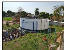
Figura 67. Reservatório RAP-01 de 1.000 m³
