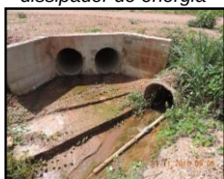
Figura 33. Deságue sem dissipador de energia
