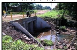
Figura 216. Canais da macrodrenagem
