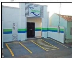
Figura 127. Fachada da Águas de Diamantino
