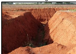
Figura 93. Início do canal de drenagem
