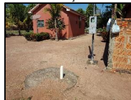
Figura 236. Fossa séptica na calçada
