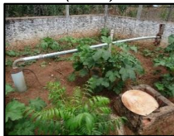
Figura 252. Poço profundo (PT-02)
