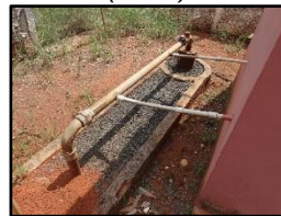
Figura 253. Poço profundo (PT-03)
