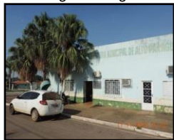
Figura 23. Departamento de Água e Esgoto
