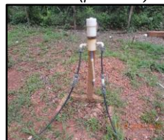
Figura 47. Clorador de contato (pastilhas)
