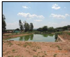
Figura 155. Lagoa facultativa aerada
