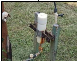
Figura 107. Dosador de cloro do tipo contato
