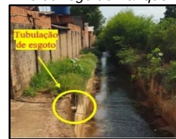
Figura 73. Lançamento no córrego do Tanque
