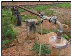
Figura 251. Poço profundo (PT-01)
