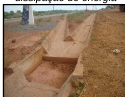
Figura 200. Dispositivo de dissipação de energia
