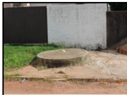
Figura 156. Vista exterior da fossa
