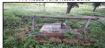
Figura 170. Vista da tampa de uma fossa rudimentar
