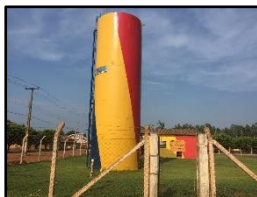
Figura 193. Reservatório elevado metálico
