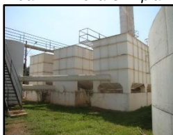
Figura 211. Vista externa da ETA Nova Olímpia
