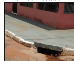
Figura 56. Boca de lobo em bom estado
