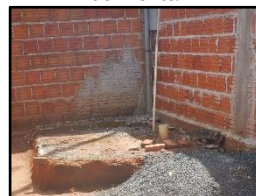
Figura 275. Vista da fossa rudimentar
