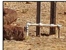
Figura 109. Ligação sem hidrômetro
