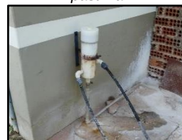
Figura 174. Clorador de pastilha
