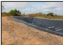
Figura 100. Vala de resíduos sólidos
