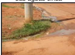
Figura 294. Lançamento das águas cinza
