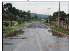
Figura 162. Ocorrência de alagamentos
