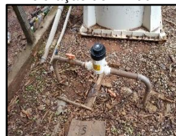
Figura 231. Sistema de cloração do PT-06
