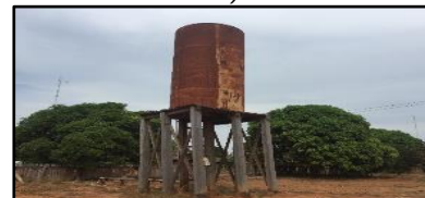
Figura 208. Reservatório elevado (10 m 3 )
