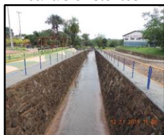
Figura 159. Trechos dos canais existentes
