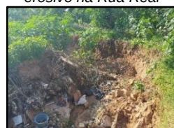
Figura 78. Processo erosivo na Rua Real
