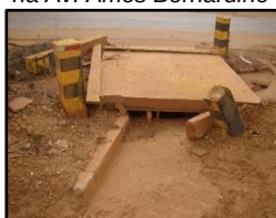
Figura 198. Boca de lobo na Av. Amos Bernardino
