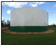
Figura 88. Reservatório apoiado metálico
