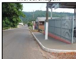
Figura 55. Via com microdrenagem
