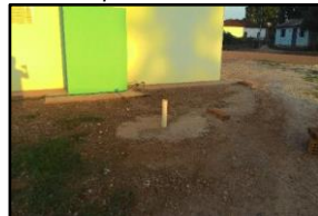
Figura 28. Vista da laje e suspiros de fossas
