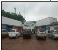
Figura 191. Estrutura da Prefeitura Municipal
