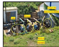
Figura 68. Conjuntos motobomba
