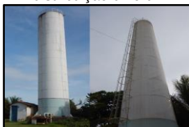
Figura 289. Reservatórios de distribuição 01 e 02
