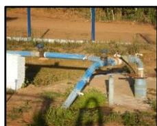
Figura 1169. Sistema de desinfecção dos poços
