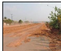
Figura 1220. Ponto de deságue com erosão
