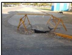
Figura 1180. Erosão em via não pavimentada
