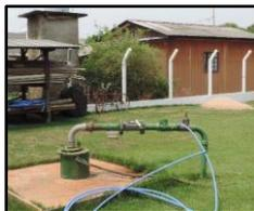
Figura 1211. Tanque de cloração
