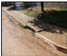
Figura 1235. Boca de lobo em via não pavimentada
