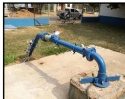
Figura 1191. Bomba dosadora de cloro
