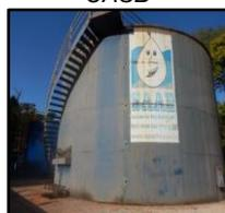
Figura 1174. Reator Biológico de Leito Móvel
