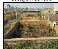
Figura 1729. Leito de secagem de lodo
