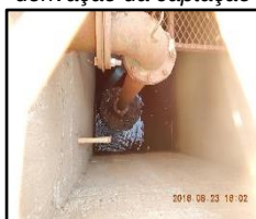
Figura 1765. Poço de derivação da captação
