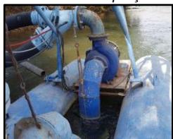
Figura 1837. Balsa utilizada na captação
