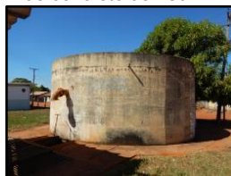
Figura 1879. Reservatório de concreto de 150 m³
