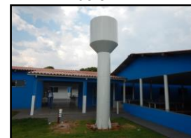
Figura 1821. Reservatório-5 de 5 m 3
