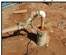
Figura 1784. Aspectos estruturais do poço 8
