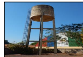
Figura 1787. Reservatório de concreto de 100 m³
