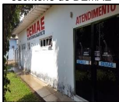
Figura 1720. Fachada do escritório do DEMA
