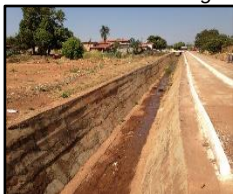
Figura 1752. Trecho canalizado do córrego
