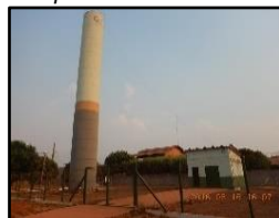
Figura 1802. Reservatório tipo torre de 250 m³
