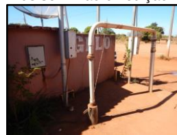
Figura 1880. Poço tubular 08 sem macromedição
