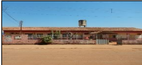
Figura 1790. Via pavimentada com meio-fio e sarjeta
