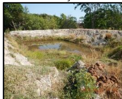
Figura 1771. Bacia de detenção
