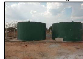
Figura 1826. Reator UASB e filtro aerado biológico
