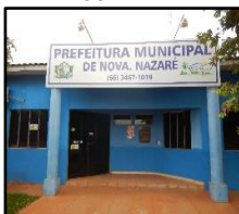
Figura 1817. Fachada do DAE
