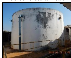
Figura 1767. Reservatório de concreto armado
