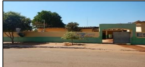
Figura 1791. Via pavimentada com meio-fio e sarjeta
