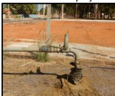
Figura 1785. Aspectos estruturais do poço 3
