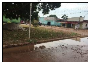
Figura 1829. Ponto de alagamento
