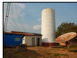
Figura 1820. Reservatório-1 de 230 m 3
