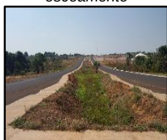
Figura 1730. Canal de escoamento
