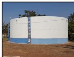
Figura 1839. Reservatório de concreto de 600 m 3
