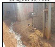
Figura 1728. Lançamento de águas servidas
