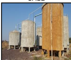
Figura 1726. Reatores UASB
