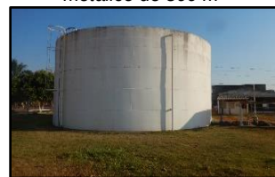
Figura 1862. Reservatório metálico de 500 m 3
