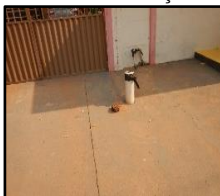
Figura 1822. Fossa instalada na calçada
