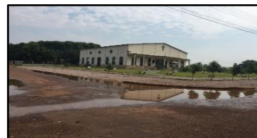
Figura 1830. Ponto de alagamento
