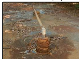
Figura 1786. Aspectos estruturais do poço 2
