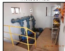
Figura 1768. Conjuntos motobomba
