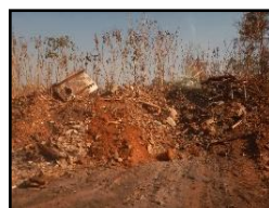
Figura 1760. Resíduos construção civil no lixão
