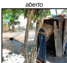
Figura 1748. Efluente de banheiro a céu aberto
