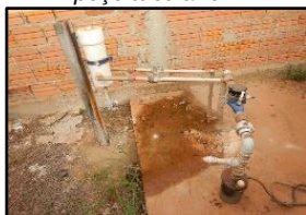
Figura 1819. Estrutura do poço tubular 04
