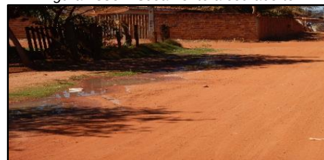
Figura 1883. Escoamento a céu aberto
