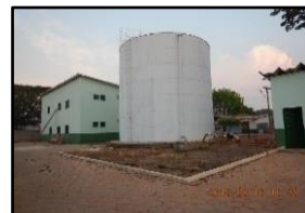
Figura 1803. Reservatório metálico de 400 m³
