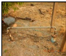
Figura 1902. Poço tubular PT-01
