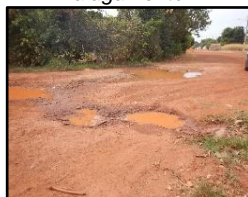
Figura 1932. Ponto de alagamento
