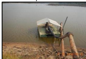
Figura 1979. Captação superficial
