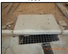
Figura 1969. Boca de lobo
