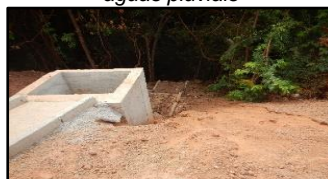
Figura 1951. Caixa coletora de águas pluviais
