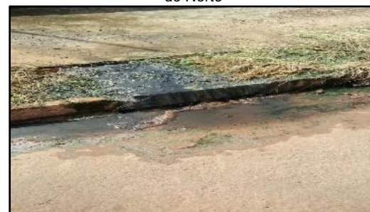
Figura 1929. Transbordamento de fossa em Porto Alegre do Norte
