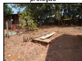
Figura 1948. Fossa rudimentar sem a devida proteção
