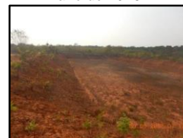
Figura 1911. Situação das lagoas em visita técnica no ano de 2016
