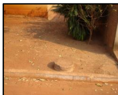
Figura 1909. Ligação domiciliar executada
