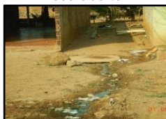
Figura 1986. Escoamento de esgoto a céu aberto
