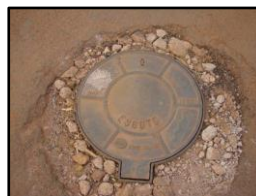
Figura 1910. Poço de visita executado
