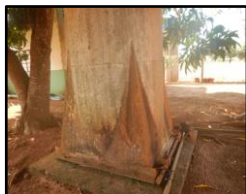
Figura 1943. Base do Reservatório-02
