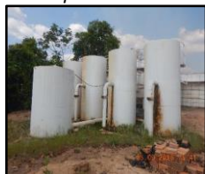
Figura 1961. ETA compacta metálica
