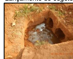
Figura 1916. Lançamento de esgoto
