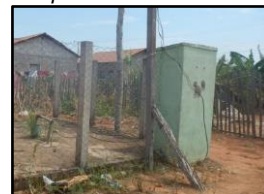
Figura 1946. Abrigo do quadro de comando
