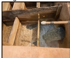
Figura 1926. Entrada de água bruta na ETA
