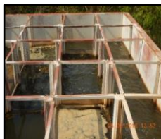
Figura 1962. Floculadores da ETA
