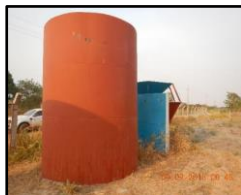
Figura 1904. Parte da ETA executada
