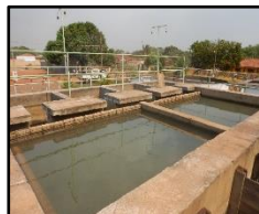
Figura 1925. Decantador - ETA
