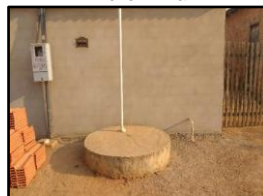
Figura 1965. Laje de fossa instalada em Santa Terezinha
