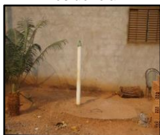
Figura 1907. Fossa instalada em uma residência
