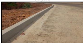
Figura 1950. Via com meio-fio e sarjeta
