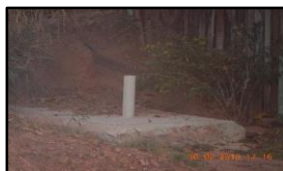
Figura 1984. Fossa instalada em Vila Rica
