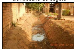
Figura 1915. Ligação clandestina de esgoto
