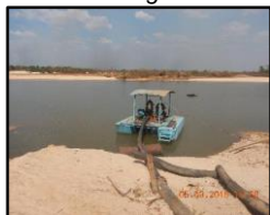
Figura 1960. Captação no rio Araguaia
