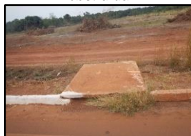
Figura 1931. Boca de lobo obstruída
