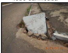
Figura 1991. Boca de lobo danificada
