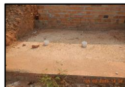
Figura 1987. Fossa instalada em Vila Rica
