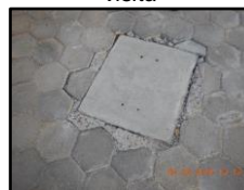
Figura 1970. Poço de visita
