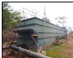
Figura 1980. ETA metálica aberta
