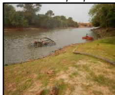
Figura 1924. Captação no rio Tapirapé
