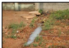
Figura 1985. Escoamento de esgoto a céu aberto
