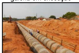
Figura 1990. Trecho de galeria em execução
