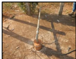
Figura 1942. Poço tubular PT-03
