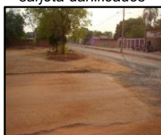
Figura 1914. Meio-fio e sarjeta danificados
