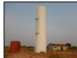
Figura 1906. Reservatório metálico instalado
