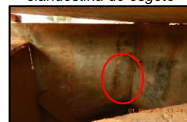
Figura 1993. Ligação clandestina de esgoto
