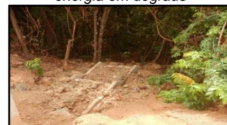
Figura 1952. Dissipador de energia em degraus
