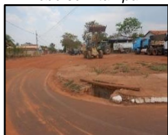
Figura 1930. Boca de lobo sem tampa
