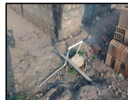
Figura 1964. Ligação domiciliar sem hidrômetro
