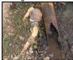
Figura 1908. Escoamento de esgoto a céu aberto
