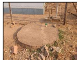
Figura 1966. Fossa instalada em Santa Terezinha
