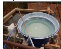
Figura 1983. Tanque de hipoclorito de cálcio
