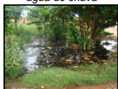
Figura 509. Acúmulo de água de chuva
