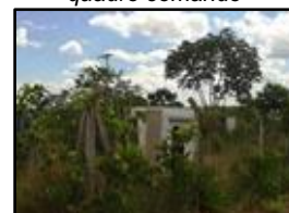
Figura 507. Vista abrigo quadro comando
