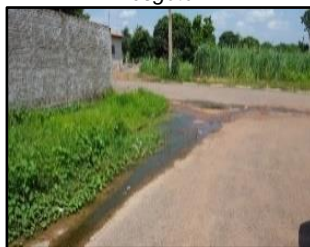
Figura 320. Lançamento de esgoto
