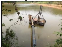
Figura 357. Captação Córrego Buracão
