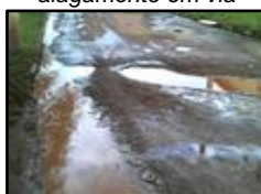
Figura 510. Ponto de alagamento em via
