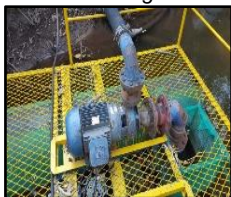
Figura 374. Captação no rio Jangada
