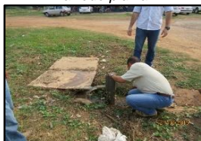
Figura 345. Ligação de esgoto na rede pluvial
