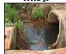
Figura 512. Ponto de descarga
