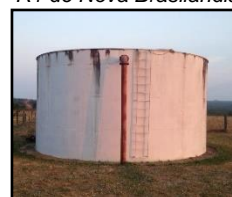
Figura 442. Reservatório R1 de Nova Brasilândia
