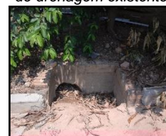
Figura 451. Dispositivo de drenagem existente
