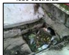
Figura 511. Boca de lobo obstruída
