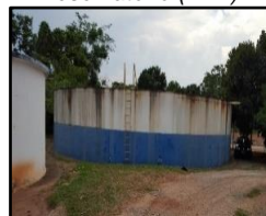
Figura 421. Vista do reservatório (ETA)
