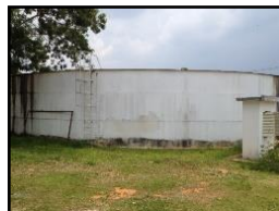
Figura 359. Reservatório ETA São Sebastião
