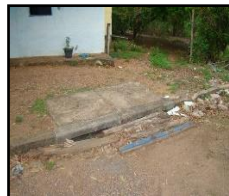
Figura 407. Boca de lobo obstruída
