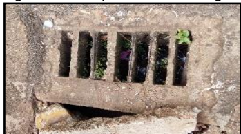
Figura 364. Dispositivo de drenagem
