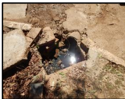
Figura 339. Manilha da rede coletora
