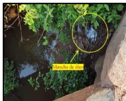
Figura 382. Mancha de óleo no córrego Passa Três
