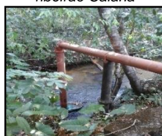
Figura 440. Captação no ribeirão Caiana
