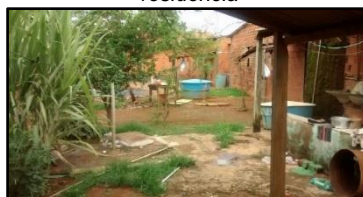
Figura 362. Fossa negra instalada numa residência
