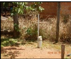
Figura 465. Fossa negra residencial
