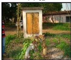
Figura 397. Poço Tubular PT-02
