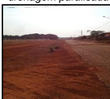
Figura 470. Obra de drenagem paralisada
