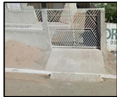
Figura 428. Rampa obstruindo o escoamento
