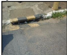
Figura 447. Boca de lobo
