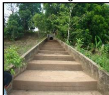
Figura 408. Dissipador de energia
