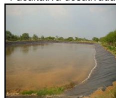
Figura 404. Lagoa Facultativa desativada
