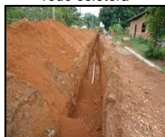
Figura 401. Instalação de rede coletora
