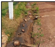
Figura 381. Valeta umidificada com esgotos domésticos
