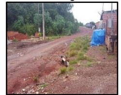
Figura 431. Erosão na Rua Alagoas
