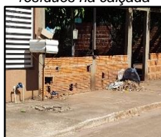
Figura 389. Lixeira e resíduos na calçada
