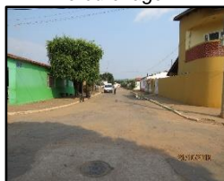
Figura 344. Rua com microdrenagem
