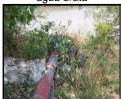
Figura 499. Adutora de água bruta
