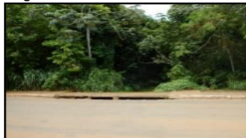
Figura 365. Rua com boca de lobo
