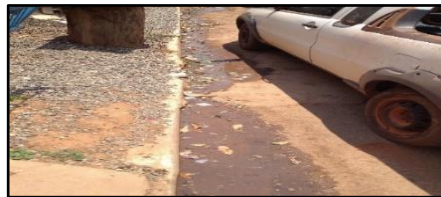
Figura 467. Escoamento de esgoto em vias públicas
