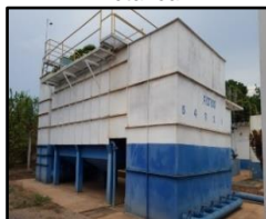
Figura 420. ETA metálica
