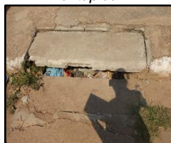
Figura 346. Boca de lobo entupida
