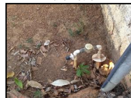
Figura 463. Cavalete com hidrômetro
