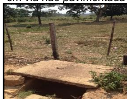
Figura 448. Boca de lobo em via não pavimentada
