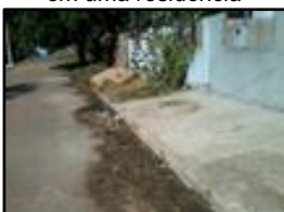
Figura 503. Fossa negra em uma residência
