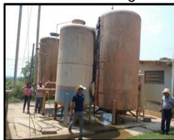
Figura 335. Estação de tratamento de água
