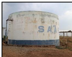
Figura 462. Reservatório no DAE
