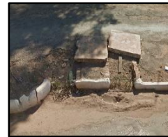
Figura 430. Boca de lobo assoreada
