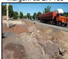
Figura 386. Erosão na margem da BR-163
