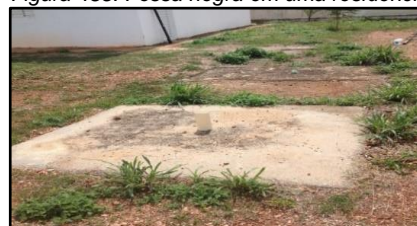
Figura 485. Fossa negra em uma residência
