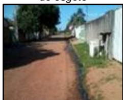
Figura 504. Escoamento de esgoto
