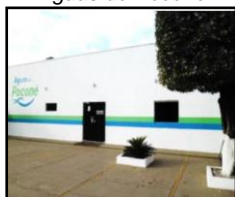
Figura 480. Fachada Águas de Poconé
