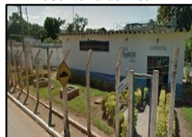
Figura 425. Fachada do escritório da Esan
