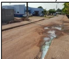
Figura 379. Lançamento de efluente na sarjeta
