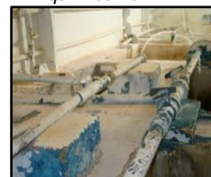
Figura 484. Casa de química na ETA
