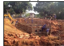
Figura 360. Obras da nova captação
