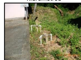
Figura 443. Cavaletes com hidrômetros
