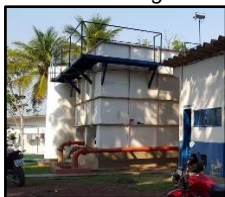
Figura 375. ETA da sede de Jangada
