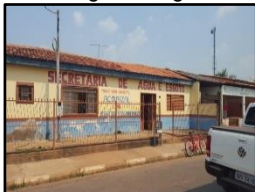
Figura 313. Sede da Sec. de Água e Esgoto
