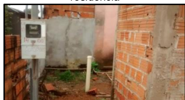
Figura 361. Fossa negra instalada numa residência
