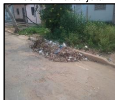
Figura 347. Acúmulo de resíduo na sarjeta
