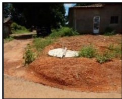
Figura 464. Fossa negra residencial
