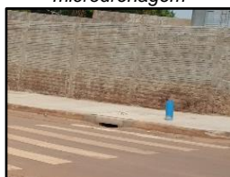
Figura 384. Rua com microdrenagem
