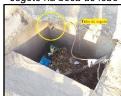
Figura 385. Ligação de esgoto na boca de lobo
