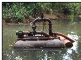
Figura 419. Captação no ribeirão Nobres
