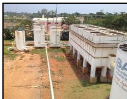
Figura 358. ETA na sede do SAAE
