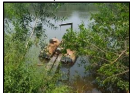
Figura 314. Captação superficial
