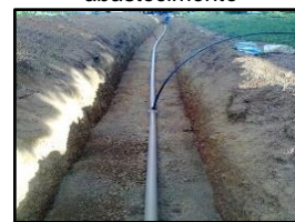
Figura 400. obra de redes de abastecimento
