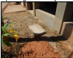
Figura 341. Caixa de passagem na calçada
