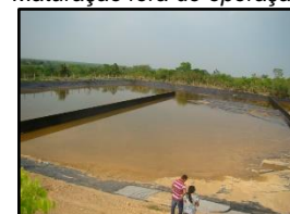
Figura 405. Lagoa de Maturação fora de operação
