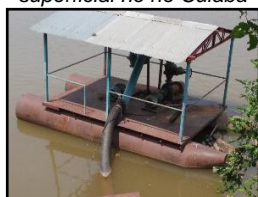
Figura 498. Captação superficial no rio Cuiabá
