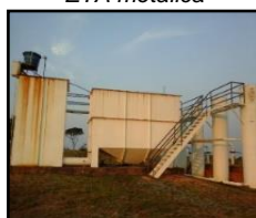
Figura 441. Vista da ETA metálica
