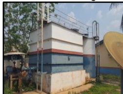
Figura 315. Estação de tratamento de água
