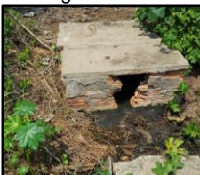
Figura 380. Extravasamento do esgoto na ETE
