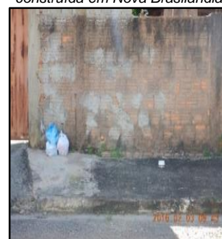
Figura 446. Fossa negra construída em Nova Brasilândia
