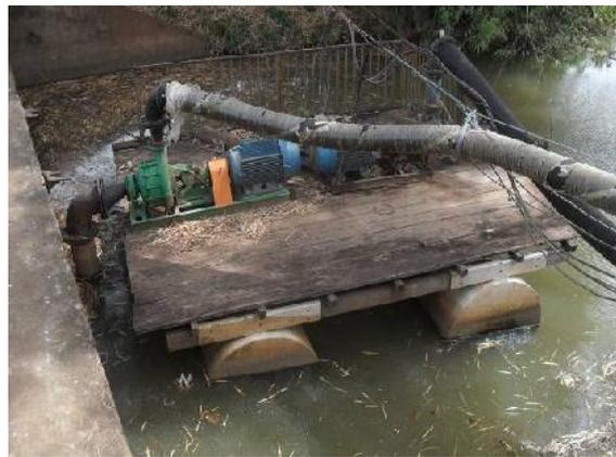
**Figura 21 – Detalhe da Bomba e Flutuador.**
