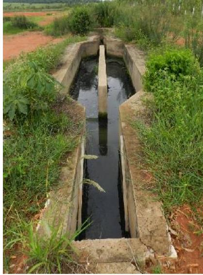
**Figura 39 – Estação de Tratamento de Esgotos - Tratamento Preliminar – Desarenador e Calha Parshall**
