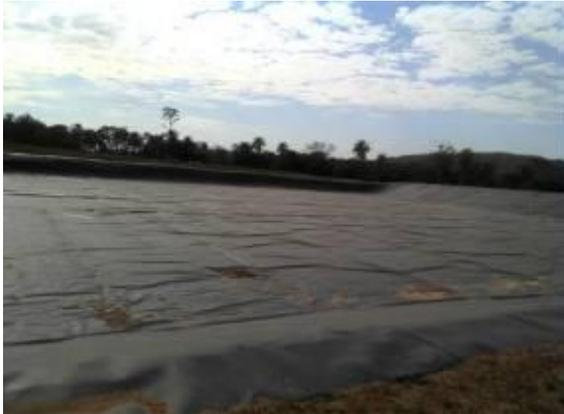
Figura 57 – Vala impermeabilizada do aterro sanitário consorciado.
