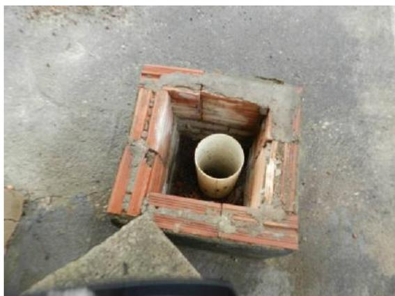
**Figura 45 – Dispositivo de Limpeza da Fossa**
