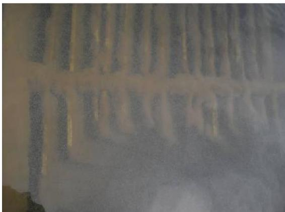
**Figura 23 – Placas do decantador**
