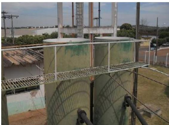
**Figura 25 – Filtros Ascendentes em Chapa Metálica**
