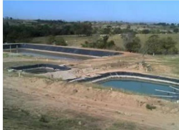
Figura 58 – Sistema de tratamento de chorume do aterro sanitário consorciado.
