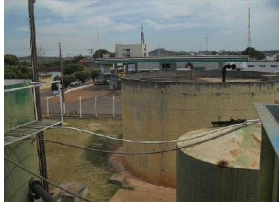
Figura 30 – ETA, Câmara de Contato e Reservatório apoiado.
