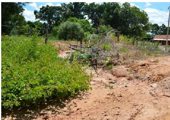
Figura 64 - Início de processo erosivo na lateral da via não pavimentada
