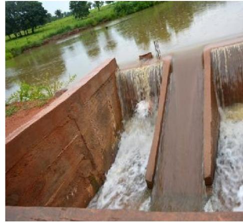
Figura 26 - Vertedor retangular da barragem
