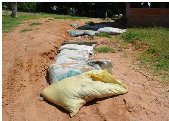
Figura 65 - Sacos de areia utilizados para conter erosão em Boa União.
