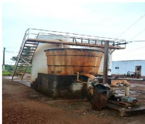
Figura 29 – Câmara de contato
