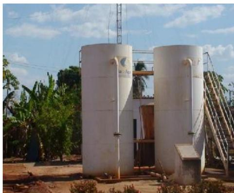
Figura 28 — Sistema de tratamento de água Filtro Russo
