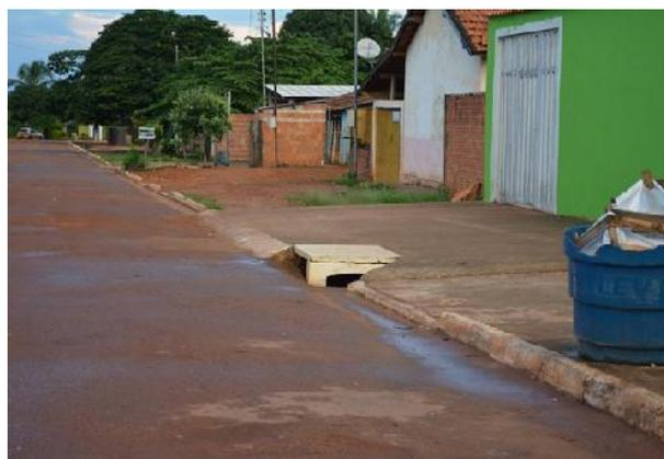
Figura 58 - Boca de lobo com duas entradas
