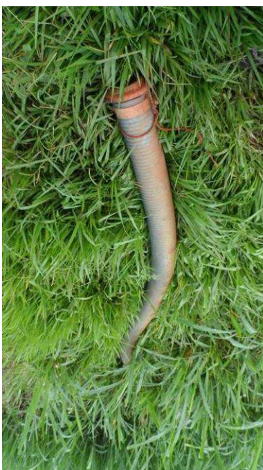
Figura 60 - Sistema de Tratamento de Esgoto – Falta de manutenção Fonte: Porto Esperidião, 2013
