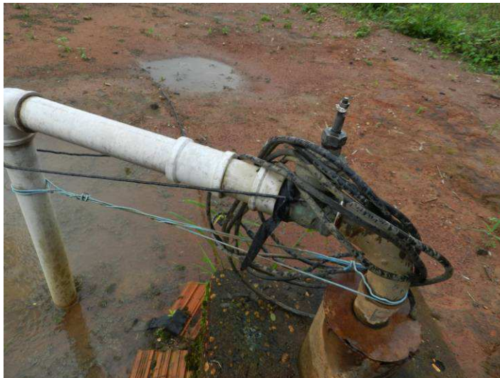
Figura 40 - Poço Tubular - Comunidade Vila Bocaiuva
