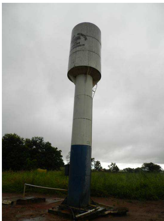
Figura 41 - Reservação - Comunidade Vila Bocaiuva
