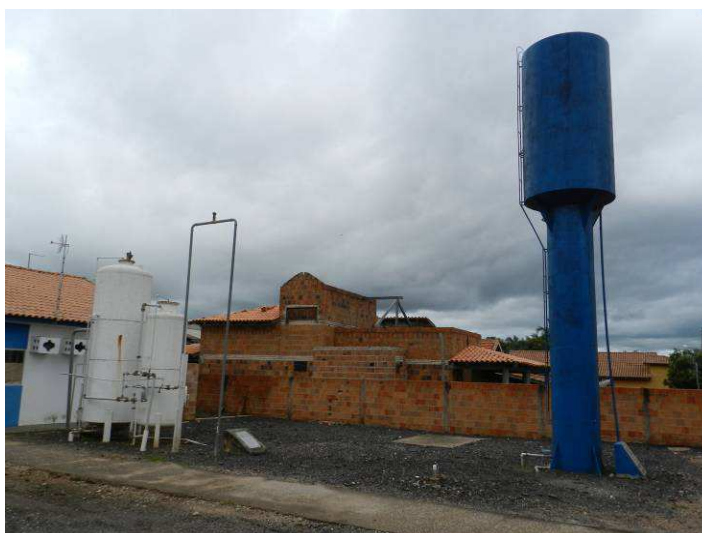
Figura 45: Reservatório Tipo Taça Vila Cardoso
