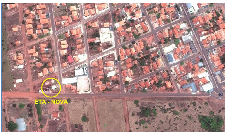
Figura 25: Estação de Tratamento de Água Nova de Porto Esperidião
