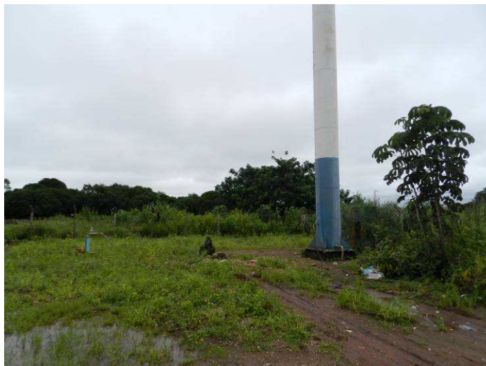
Figura 39 - Reservação - Comunidade Vila Picada
