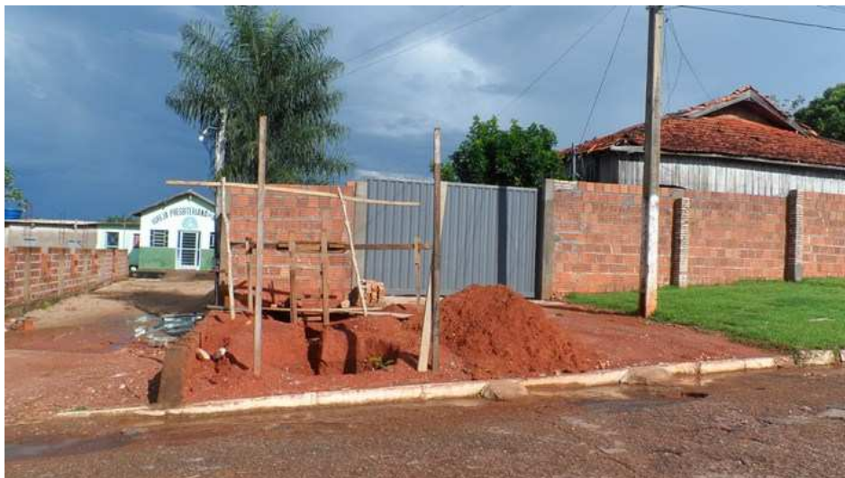
Figura 65: Construção de Fossa Rudimentar à frente da residência – Área Urbana
