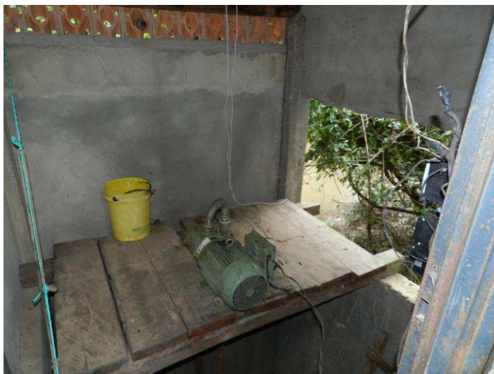
Figura 44: Bomba Captação superficial Vila Cardoso – Rio Aguapeí
