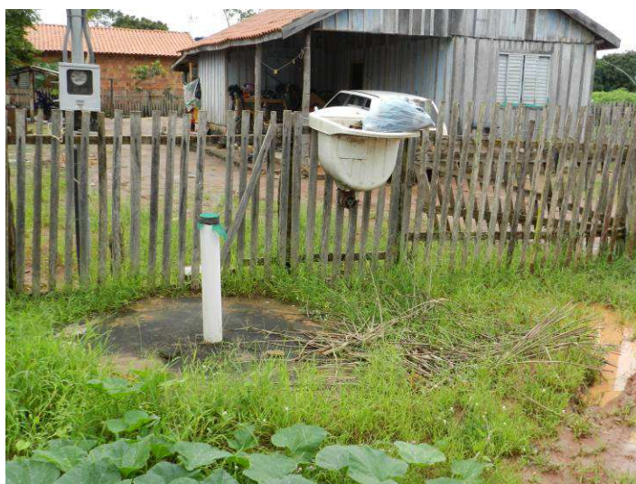
Figura 62: Fossa Rudimentar à frente da residência – Vila Picada
