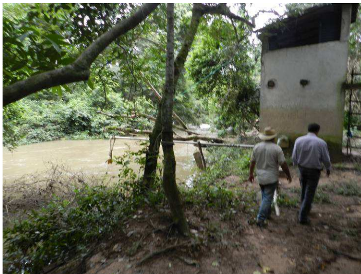
Figura 42: Captação superficial Vila Cardoso – Rio Aguapeí
