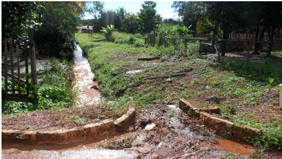
Figura 68: Início de erosão no final da via pavimentada
