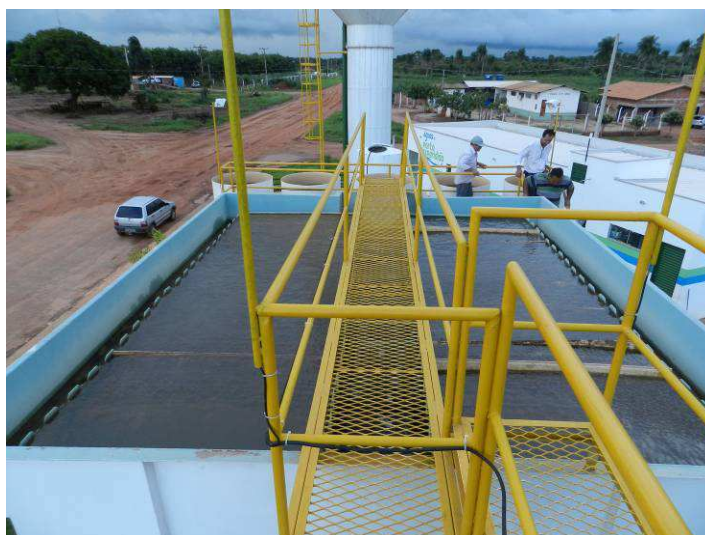
Figura 55: ETA – Decantação
