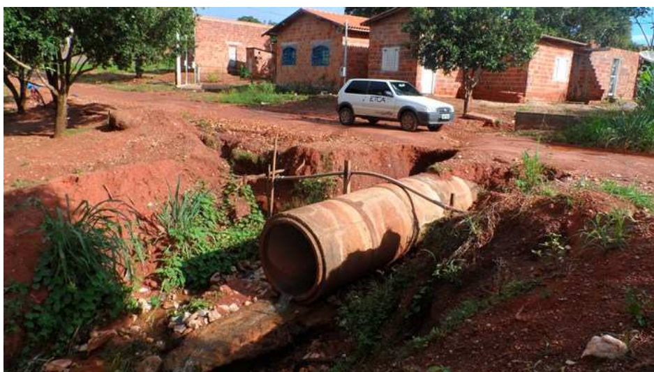
Figura 70: Erosão em via não pavimentada (tubos de drenagem aparentes)
