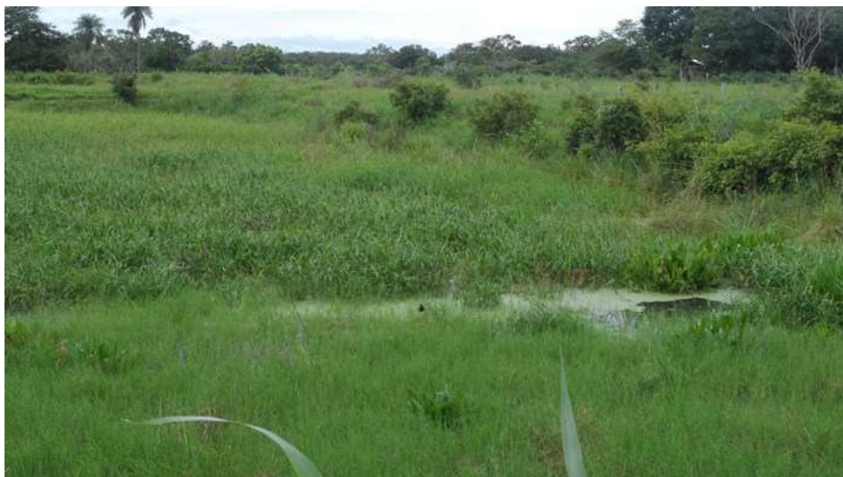
Figura 61: Sistema de Tratamento de Esgoto – Abandonado Fonte: Porto Esperidião, 2013.
