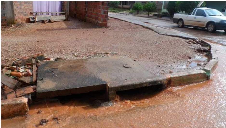
Figura 74: Bocas de lobo.
