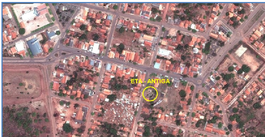
Figura 24: Estação de Tratamento de Água Antiga de Porto Esperidião
