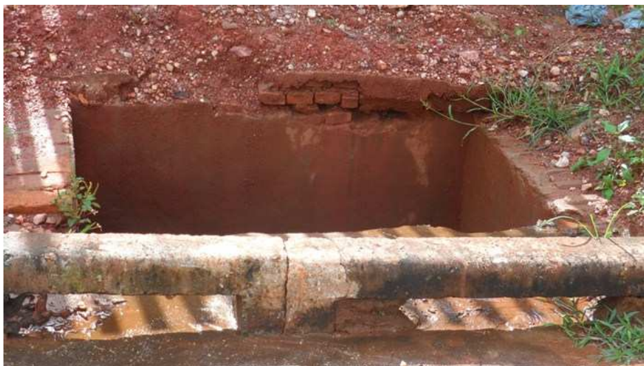
Figura 76: Boca de lobo sem tampa (sem manutenção)
