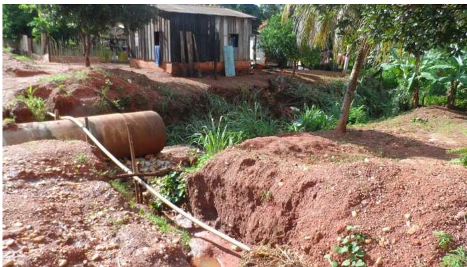
Figura 69: Erosão em via não pavimentada (tubos de drenagem aparentes)
