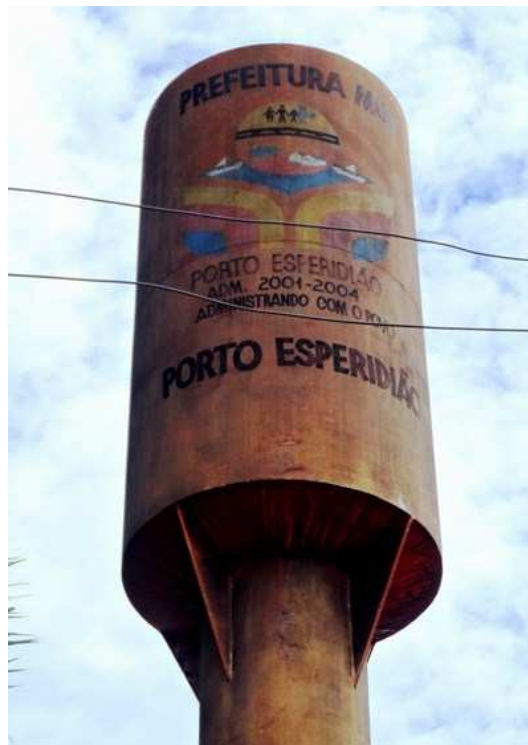
Figura 52: Reservatório – Comunidade Asa Branca
