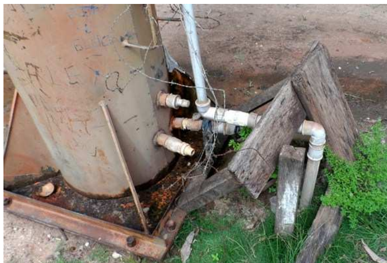
Figura 50: Base do Reservatório – Comunidade Asa Branca
