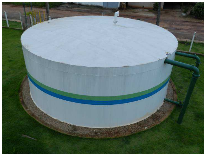
Figura 56: Reservatório (capac. 200m 3 )
