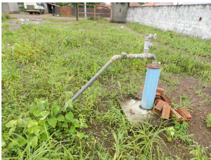
Figura 38 - Poço Tubular - Comunidade Vila Picada
