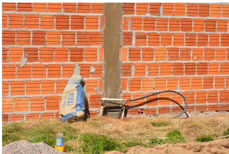
Figura 48: Cavalete sem hidrômetro – Comunidade Pedro Neca
