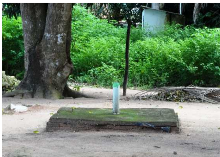
Figura 64: Fossa Rudimentar à frente da residência – Asa Branca
