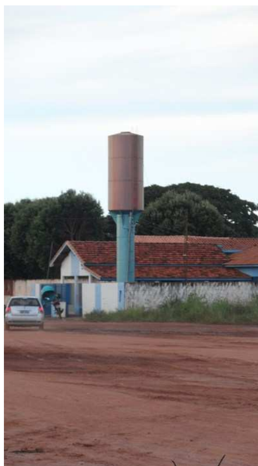
Figura 46: Reservatório principal – Comunidade Pedro Neca
