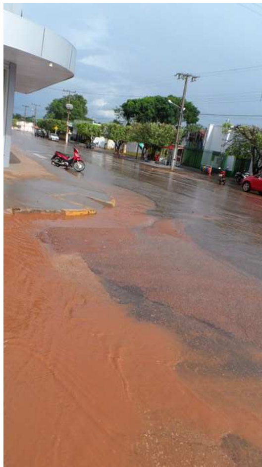
Figura 72: Via pavimentada, sem escoamento ou boca de lobo
