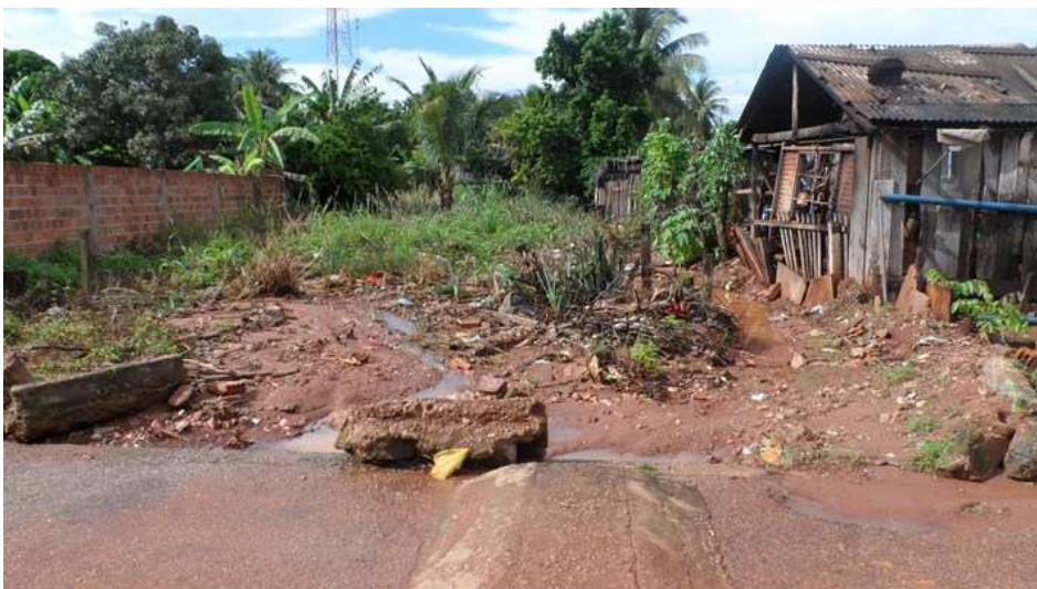
Figura 75: Erosão (necessidade de dissipador)
