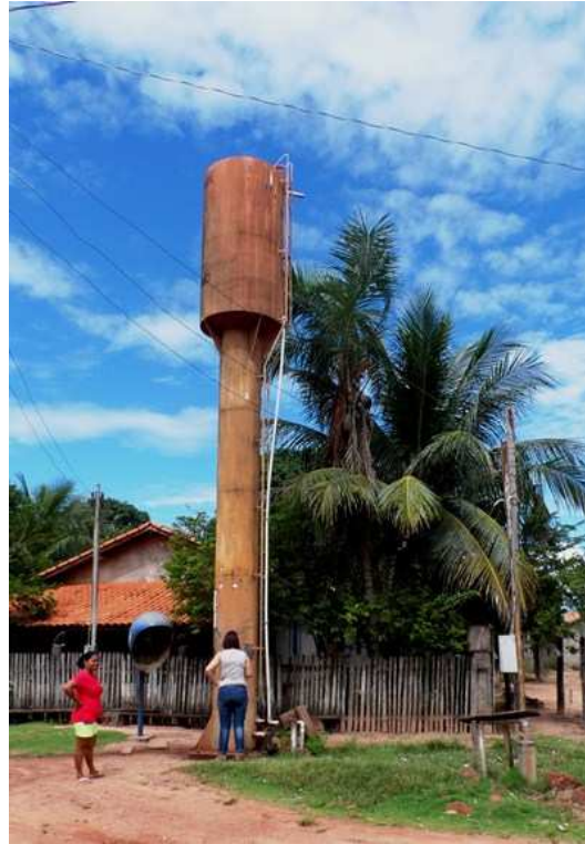
Figura 51: Reservatório – Comunidade Asa Branca
