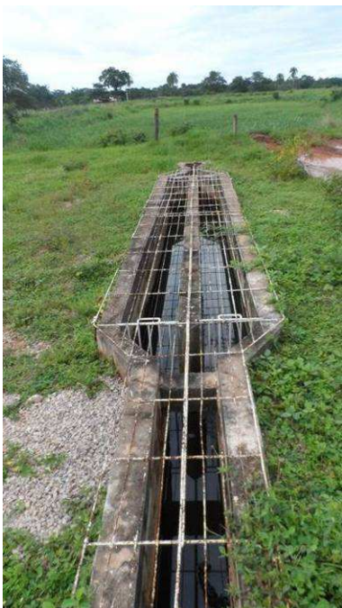
Figura 59: Sistema de Tratamento de Esgoto – Desarenador Fonte: Porto Esperidião - ENSEMA, 2012
