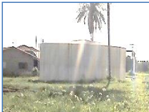
Figura 31: Reservatório Apoiado RAP - 01
