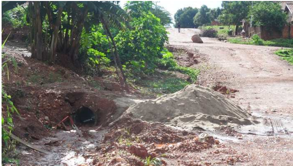
Figura 71: Erosão em via não pavimentada
