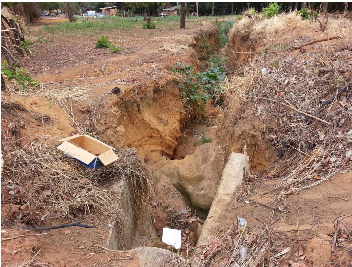
**Figura 11 - Erosão devido a lançamentos sem dissipadores no Córrego Velho Joana**
