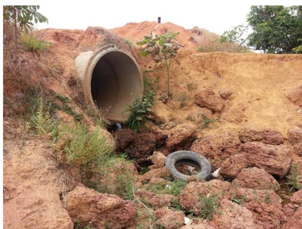
**Figura 17 - Galeria que reúne todo volume efluente do lago: Lançamento final**
