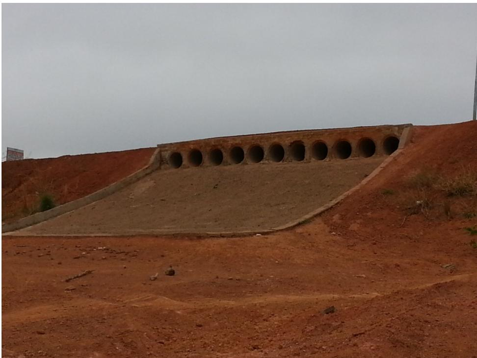
**Figura 16 - Estrutura do Efluente do lago, galerias e Vertedouro**
