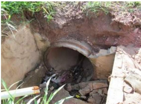
**Figura 68 - Erosão em via não pavimentada causada pelo lançamento de águas pluviais sem a dissipação de energia.**
