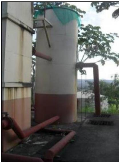
**Figura 28 - Filtros e Clorador (pré tratamento)**
