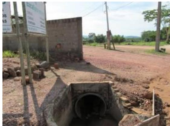
**Figura 69 - Erosão em terreno causada pelo lançamento de águas pluviais sem a dissipação de energia.**
