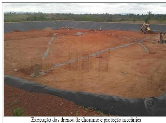
Execução dos drenos de chorume e proteção mecânica
