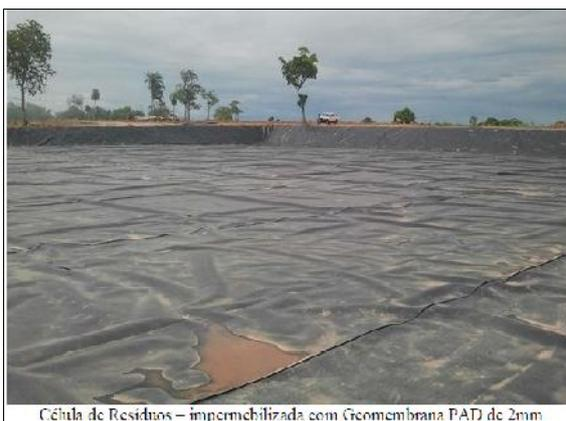
Célula de Resíduos – impermeabilizada com Geomembrana PAD de 2mm
