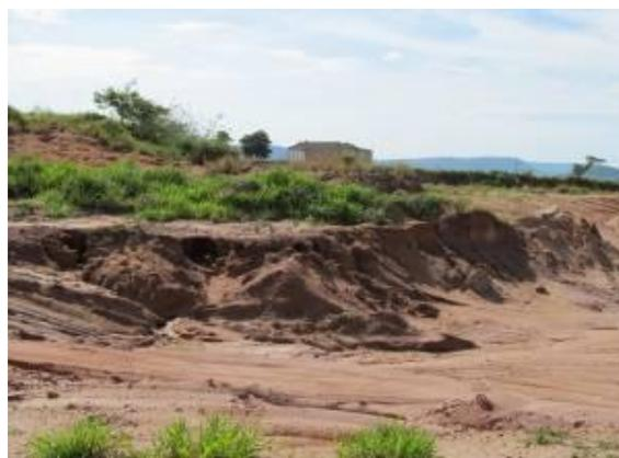
**Figura 67 - Erosão em via não pavimentada causada pelas chuvas pela falta de drenagem.**
